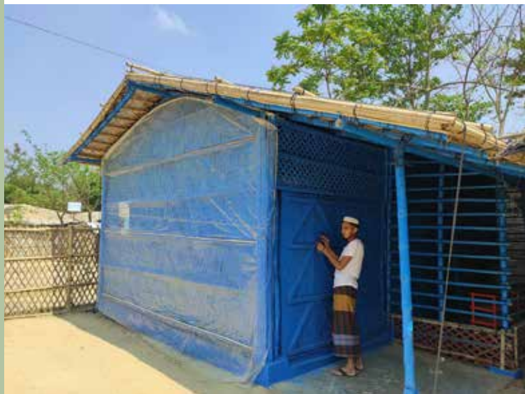
Construcție 4. Extindere. Structură pe un singur nivel. (Sus) Muncitor care fixează structura acoperișului în timpul lucrărilor de renovare. (Jos) Centru de învățare după renovare, îngrijit de un îngrijitor din comunitatea Rohingya. / Camp -4 Extension: Single storied structure: (Up) Worker fixing the roof structure during renovation work. (Down) Learning center after renovation, looked after by a caretaker from the Rohingya community. Fotografii / Photos: AKM Ferdous
