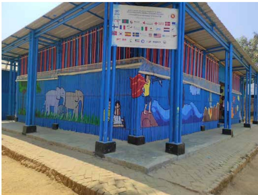
Structura - 4: Centrul de instruire (Sus)- Muncitori în timpul lucrărilor de construcție. (Jos): Centrul de instruire după renovare. / Camp -4: Training Centre (Top)- Workers engaged in construction work during renovation. (Bottom): The training center after renovation.
